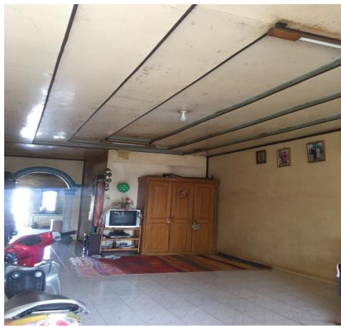
Kedaaan Dinding dan Lantai pada Desa Raya Berastagi
