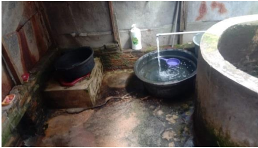
Gambar 1.4 Kondisi Jamban warga dan tempat penampungan air yang terbuka
