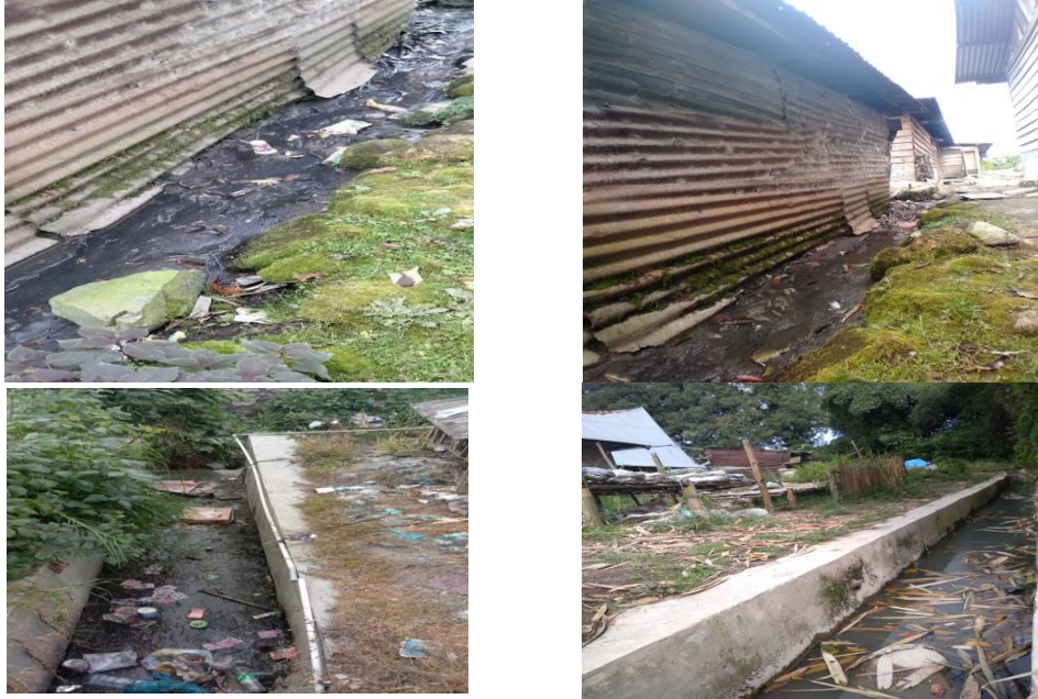
Gambar 1. Foto Saluran Pembuangan Air Limbah di Desa Partungkonaginjang Kecamatan Harian Kabupaten Samosir
