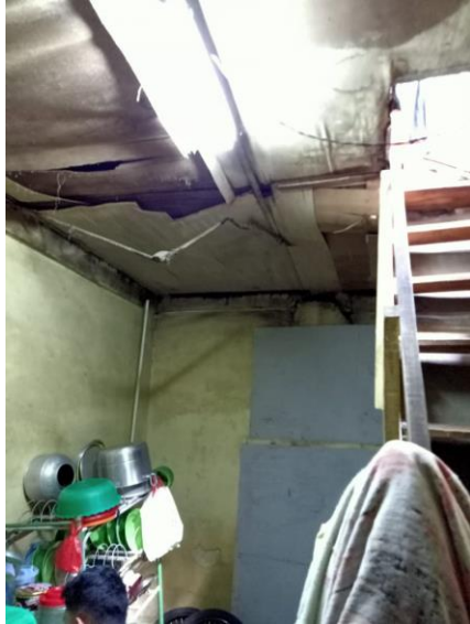
Gambar 7. Langit-langit rawan kecelakaan di Kelurahan Padang Mas Kecamatan Kabanjahe 2021
