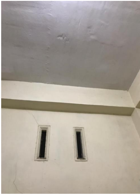
Ventilasi rumah yang 10 % dari luas lantai
