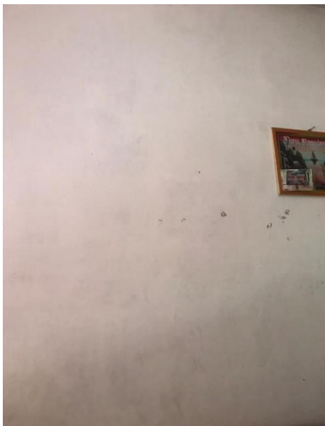
Dinding yang sudah di plester
