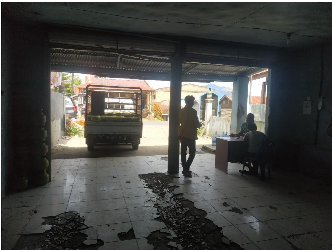
Kondisi Lantai Depot Sipiso-piso Water
