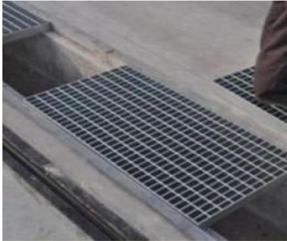
Gambar 4.4 Tutup Saluran Drainase (KPS Steel)
