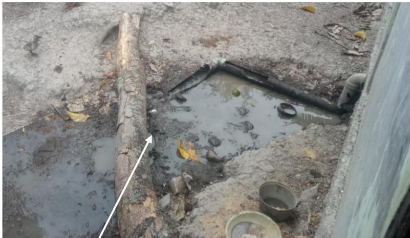
Gambar 4.2 Penanganan limbah *grey water* tanpa menggunakan Saluran Pembuangan Air Limbah
