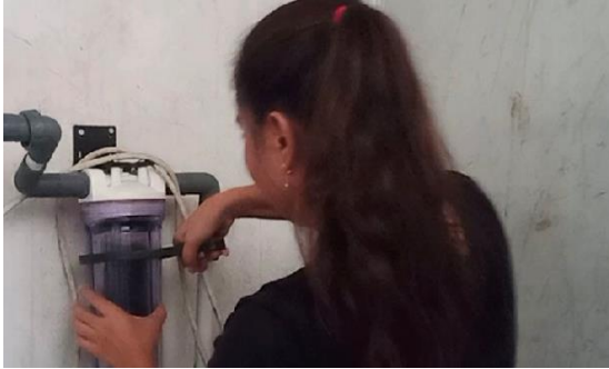
Gambar 7. Pemasangan Tabung filter ke pipa
