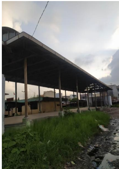
Ruang Tunggu yg tidak digunakan lagi
