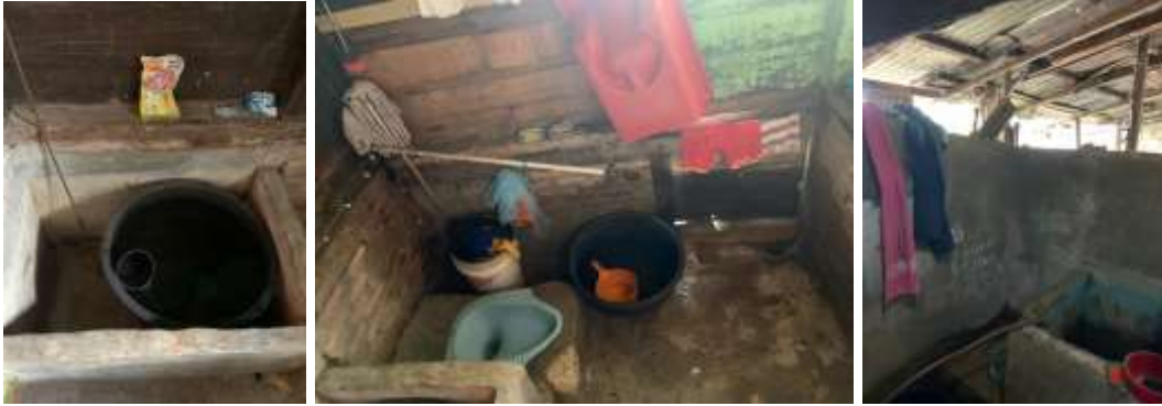
Inspeksi Jamban Sehat
