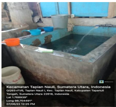
Penyediaan air bersih
