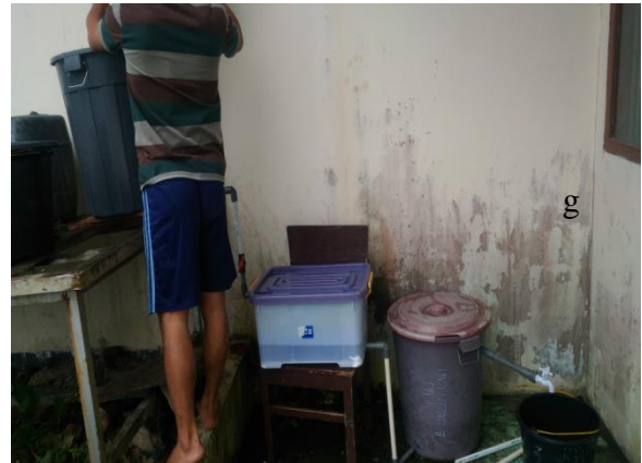
Gambar6: Unit pengolahan air kombinasi koagulasi filtrasi
