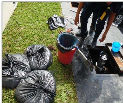
Pada bak ini dilakukan Penginjeksian koagulant dan flocculant pada air limbah. Selain itu pada bak ini juga dilakukan sedimentasi akhir dan penambahan bahan desinfektan berupa kaporit yang berfungsi untuk membunuh bakteri yang bersifat patogen seperti E-coli. Untuk proses pembersihan flok-flok dari bak ini dikumpulkan secara manual kedalam kantong plastik dan pembuangan akhir diangkut oleh Pihak Dinas kebersihan.
