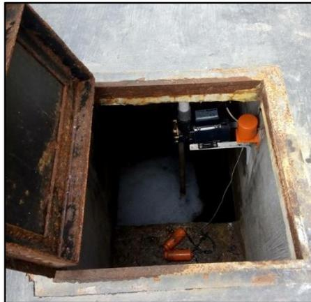
Fungsi bak aerasi adalah sebagai tempat dimana terjadinya proses penambahan udara/oksigen dalam air dengan menggunakan blower untuk mendukung pertumbuhan bakteri aerob yang ditambahkan ke bak aerasi tersebut. Pada bak ini dilakukan penambahan Enzym-Aerobik sebanyak 3 liter dalam jangka waktu 1 minggu sekali. Bakteri yang digunakan adalah bakteri prima enzyme yang berfungsi untuk mereduksi zat-zat pencemar yang tersisa.
