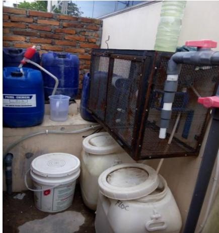
Koagulant berfungsi untuk menjernihkan air limbah sedangkan fungsi flocculant untuk mengikat kotoran pada proses penjernihan. Bahan koagulant dan flocculant yang diinjeksikan dengan menggunakan Dosing pump ke bak sedimentasi, bahan koagulant/ flocculant yang diinjeksikan bersifat cair sehingga tidak dilakukan pengadukan.
