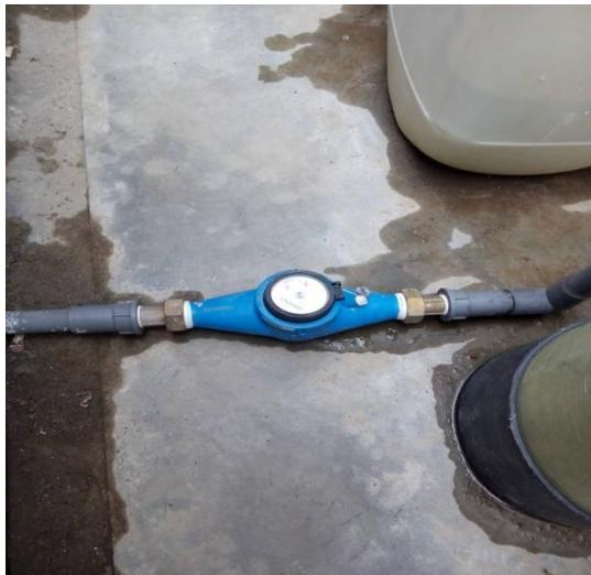
Fungsi flow meter untuk mengukur debit air limbah.
