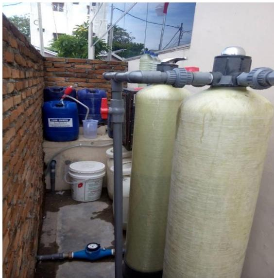
Fungsi tabung filter untuk mengurangi Total suspended solid (TSS), Amoniak, Bau, BOD dan COD dikarenakan Media ini dilengkapi Zeolit, carbon aktif, pasir aktif dan green sand. Untuk proses pengambilan sampel diambil dari tabung filter yang dilengkapi dengan kran untuk mempermudah pengambilan sampel.
