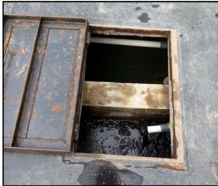
Fungsi dari bak Biofilter I dan II ini adalah untuk pengolahan air limbah. pada bak I penyaringannya menggunakan pasir silika yang ukuran pasirnya lebih kasar dan pada bak ke II dengan menggunakan pasir silika yang ukuran pasirnya lebih halus. Bak ini juga berfungsi sebagai tempat berkembang biaknya mikroorganisme, sehingga dengan adanya media biofilter ini akan memperluas kontak area antara bakteri dan air limbah.
