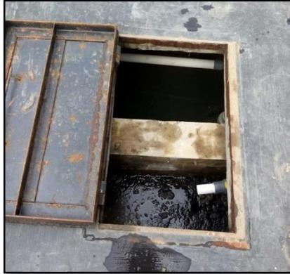
Fungsi bak penampungan adalah untuk menetralkan Ph air limbah. Seluruh air limbah dari ruangan dialirkan ke dalam bak penampung kecuali air limbah dari dapur yang diproses di dalam grease trap terlebih dahulu.
